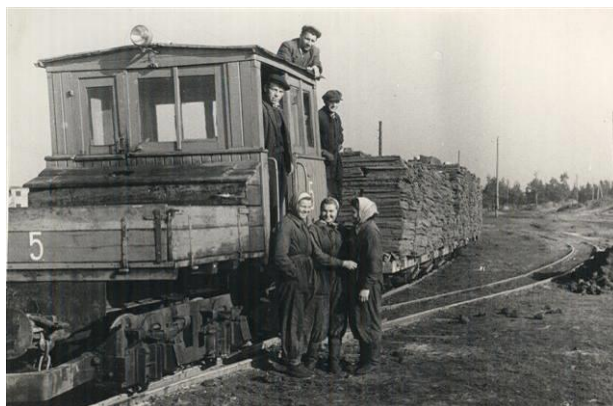
1. foto. Gatavo kūdras izolācijas plāšu transportēšana uz platformām pa šaursliežu dzelzceļu Baložos ar MY34Д sērijas lokotraktoru, aptuveni 1960-tie gadi. Foto no Baložu pilsētas bibliotēkas krājuma.
