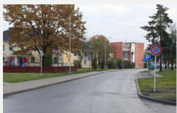
Skolas ielas rekonstrukcija
