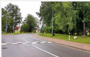
Rāmavas ielas 1. kārtas rekonstrukcija
