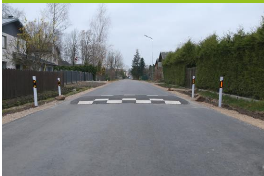
Atjaunots ceļa segums Cālišpurva ielā, Tīturgā
